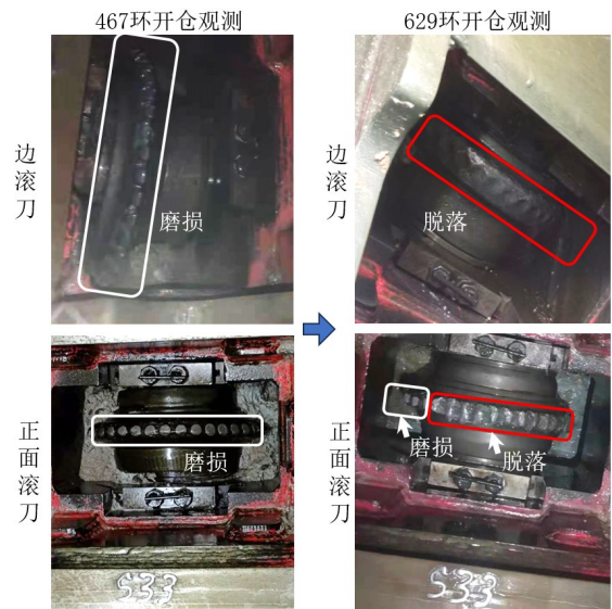
图 12 镶齿滚刀磨损及损坏过程
