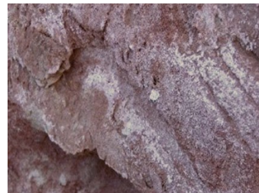
(d) Salt crystallization weathering [58]
