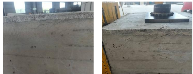
(a) 拔出-劈裂破坏(R) (b) 劈裂破坏(L)
