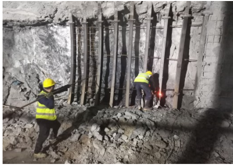
(a) 单侧台阶扩挖法中的左拱脚支护施工
