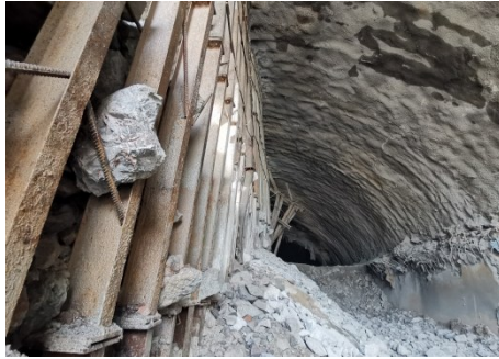
(b) 单侧 CD 扩挖法中的右导洞开挖施工
