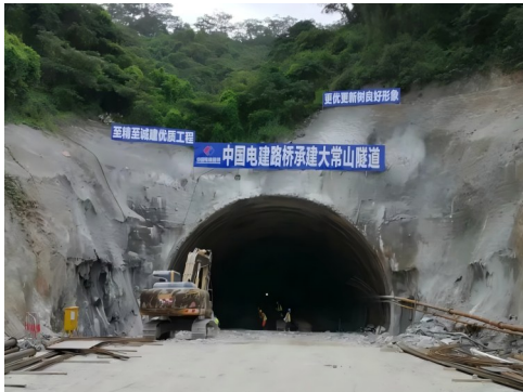
图1 大常山隧道施工现场 Fig.1 Dachangshan tunnel construction site
